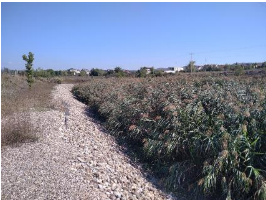
Foto të hapësirës ku zhvillohen bimët duke u ushqyer nga ujërat e ndotura dhe bëhet pastrimi i tyre.
