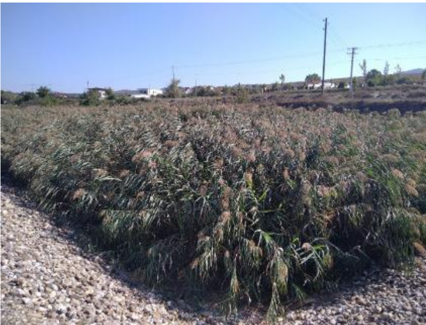
Foto të hapësirës ku zhvillohen bimët duke u ushqyer nga ujërat e ndotura dhe bëhet pastrimi i tyre.
